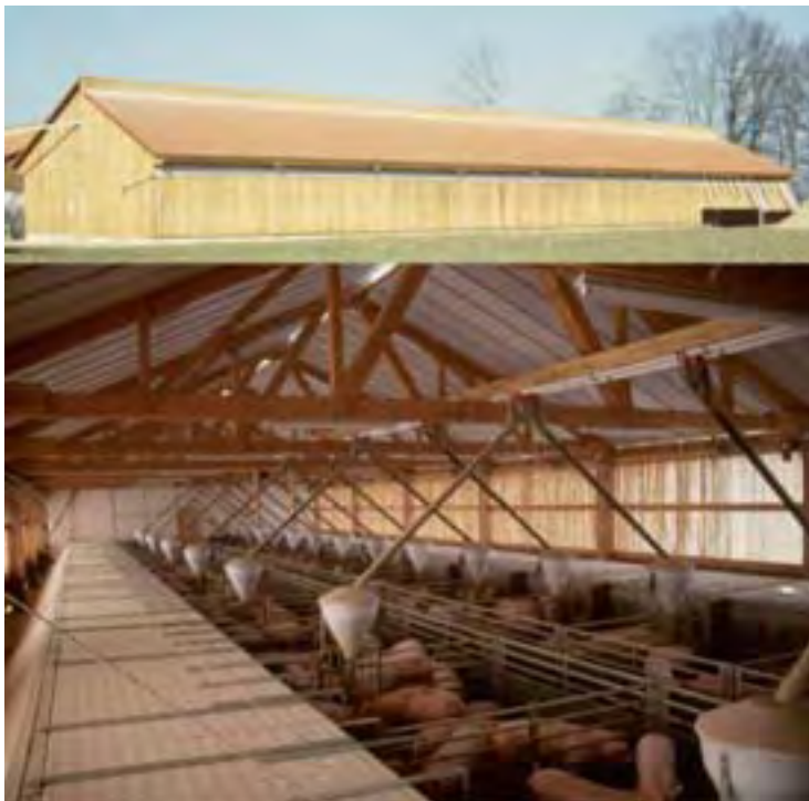
Bild 27: Ansicht des Kistenstalles von Außen (oben) und im Innenraum (unten)
