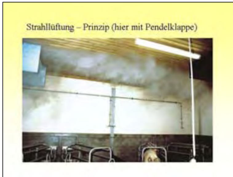
Bild 6: Erwünschtes Strömungsbild bei der Strahl Lüftung mit Wandelementen entlang der Stalldecke; sichtbar durch Zugabe von künstlichem Nebel
