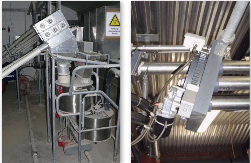
Abbildung 16: Darstellung einer Druckluftanlage und eines Rotationsverteilers
