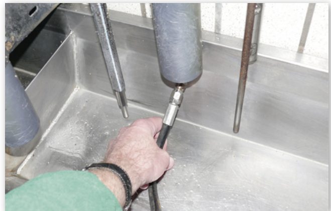
Abbildung 8: Spülen eines Leitungsablaufs in den Trog
