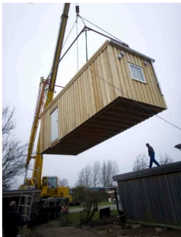
Abbildung 18: Mobile Heizzentrale (60 kW) von NissenEnergie auf dem Campingplatz „Nordsee Camping zum Seehund“ (Foto: Bielenberg/Nissen)
