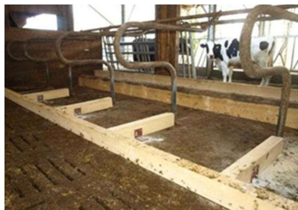
**Abbildung 6:** Der Grundrahmen von Tiefboxen kann aus Beton oder auch aus Holz erstellt werden.
