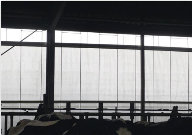
Abbildung 5: Geschlossene und verschmutzte Windnetze (Quelle: Pelzer)
