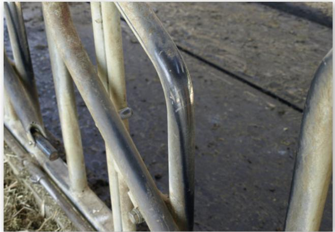
Abbildung 4: Fressgitter mit deutlichen Scheuerstellen (Quelle: Pelzer)
