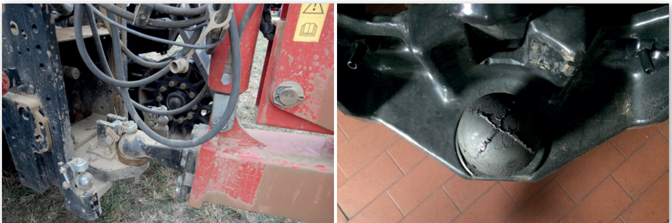
Abbildung 7: Staub und Dreck schädigen die Kugelkopfkupplung 80. Mindestens einmal je Einsatztag ist die Verbindungseinrichtung zu warten (Quelle: Vaupel, Gehring)
