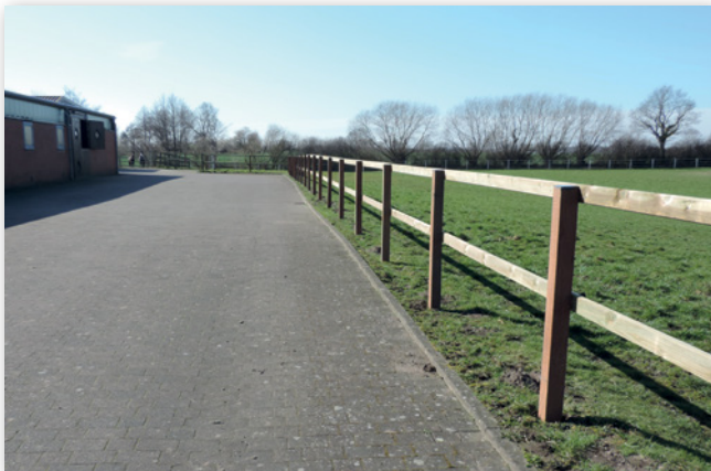
Abbildung 7: Festzaun mit Pfählen und Querverbindungen aus Holz (© Zaunbau Berger)
