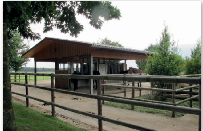
Abbildung 15: Kombinationszaun mit ummantelten Drahtlitzen (© FN/RR1)
