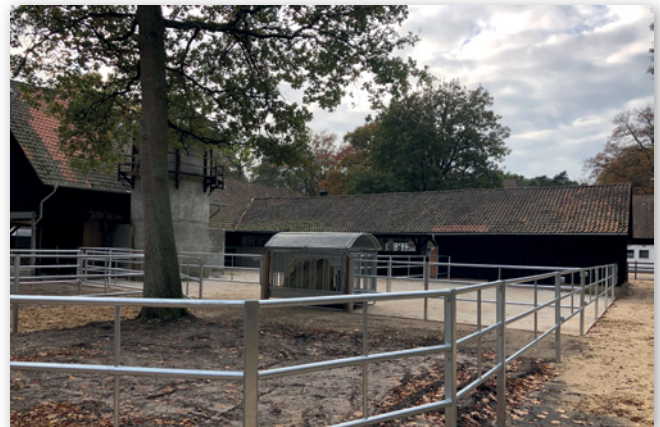
Abbildung 8: Festzaun mit Pfählen und Querverbindungen aus Metall (© Horse Pferdesportsysteme)
