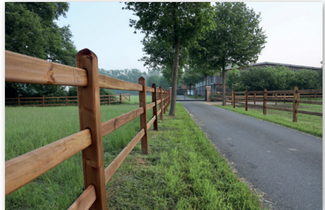
Abbildung 13: Festzaun an einer Zufahrt (© Zaunbau Berger)
