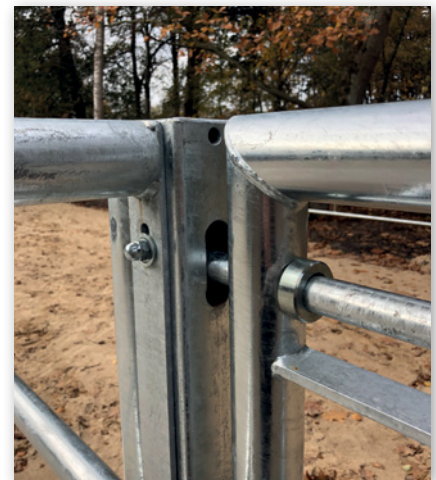
Abbildung 11: Tor mit Anschlag links, weil das Pferd rechts geführt wird; mit der linken Hand zu öffnender Torverschluss (© Horse Pferdesportsysteme)
